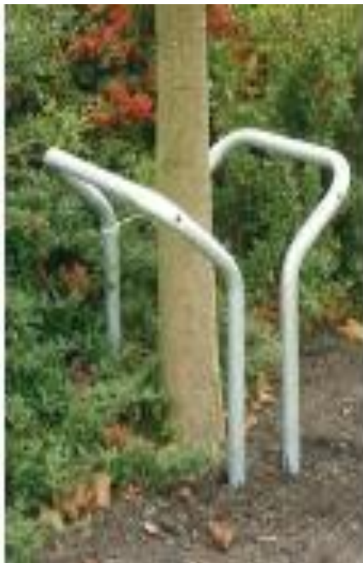
Załącznik 11.2 - osłona w formie rury z żarowo ocynkowanej rury Ø 40 mm
