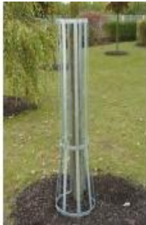
Załącznik 11.2 - osłona w formie rury z żarowo ocynkowanej rury Ø 40 mm
